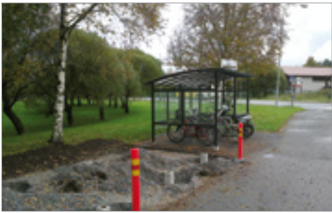
Uusipyöräteline. Yksi valmiina ja toisestakin jo idut näkyvissä
