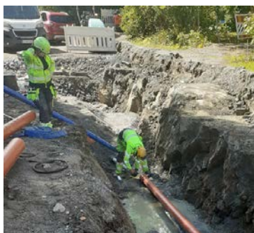
Putkiliitokset kaivannossa ovat käsityötä.
