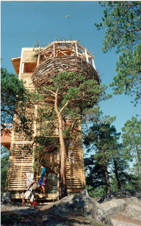
Tuhoutunut Katteluksen Linturtorni.
