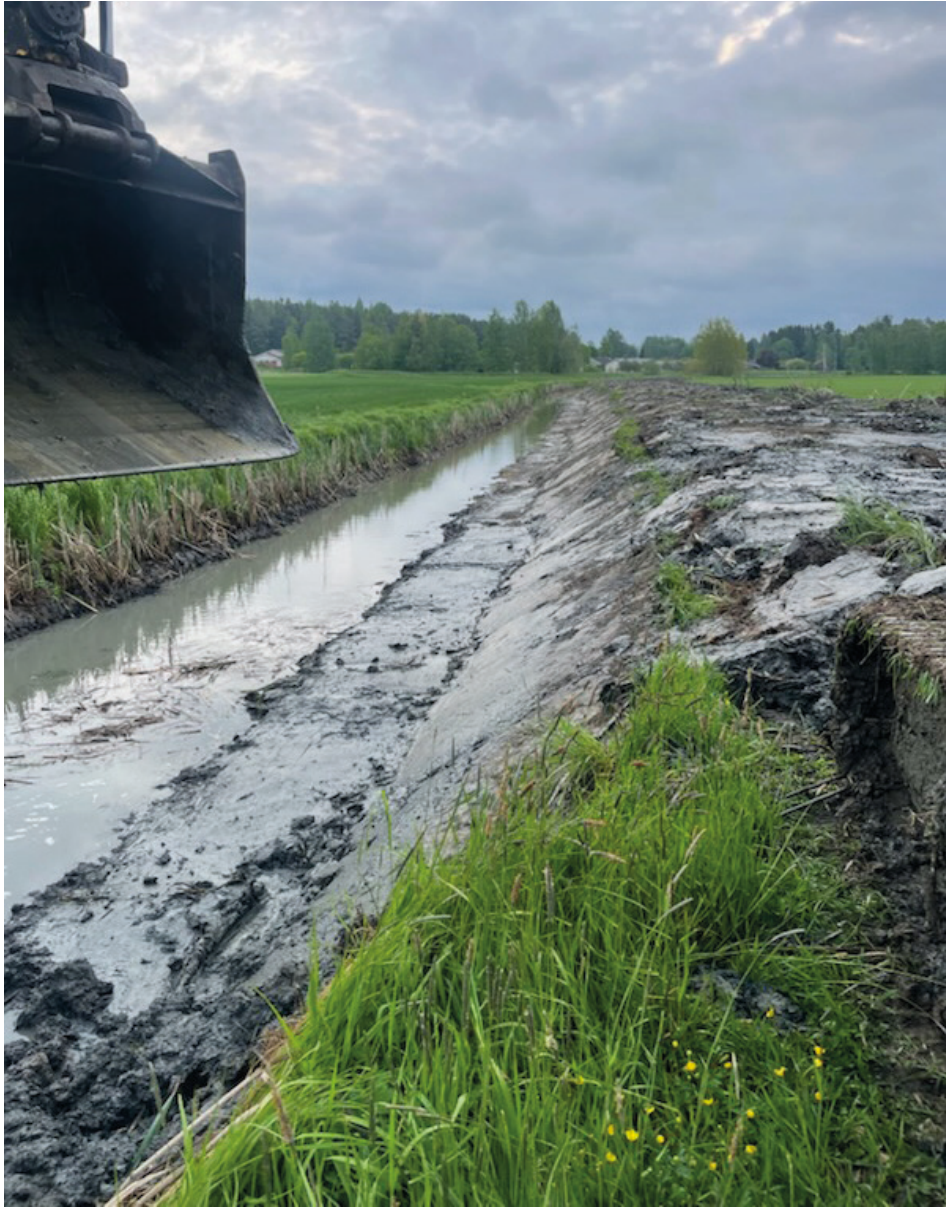
Kaksitasouoman rakentaminen.
